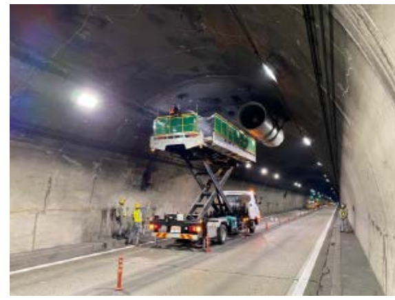
ジェットファンの設置・点検
