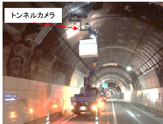
トンネルカメラの設置・点検
