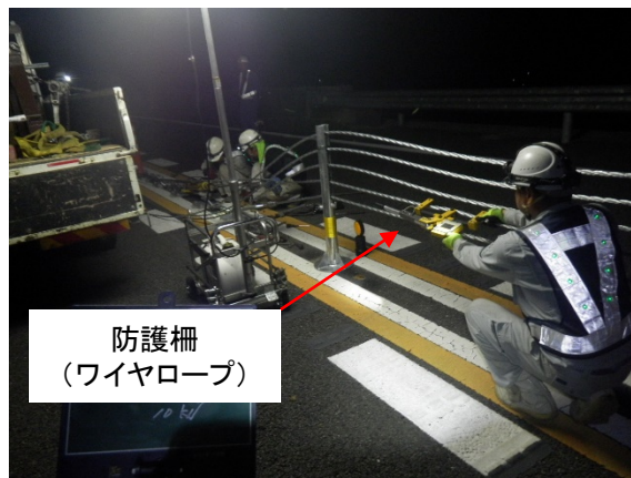
防護柵(ワイヤロープ)の設置
