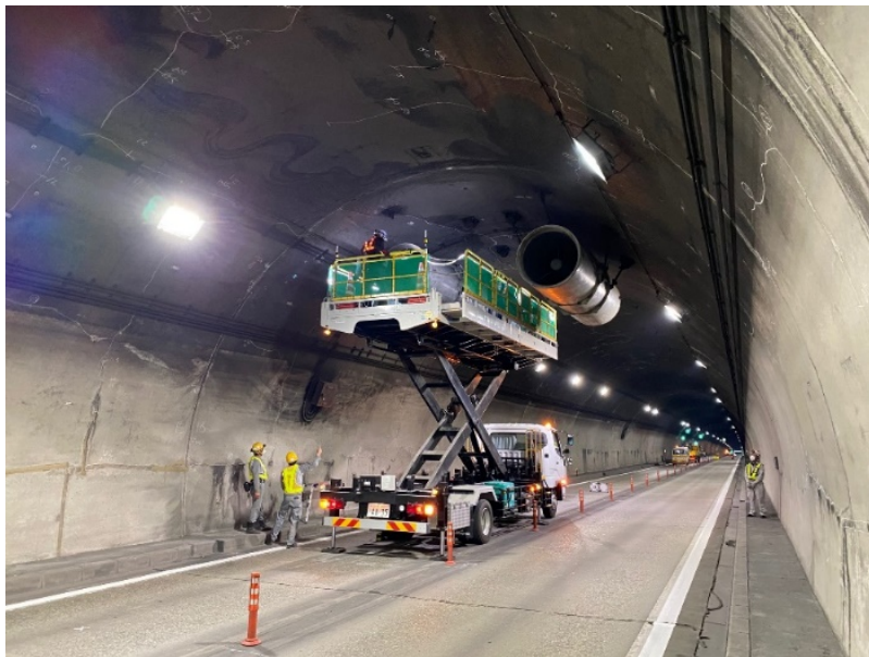
①ジェットファン（換気設備）の修繕
