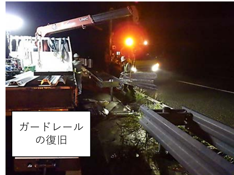
③ガードレール等の復旧
