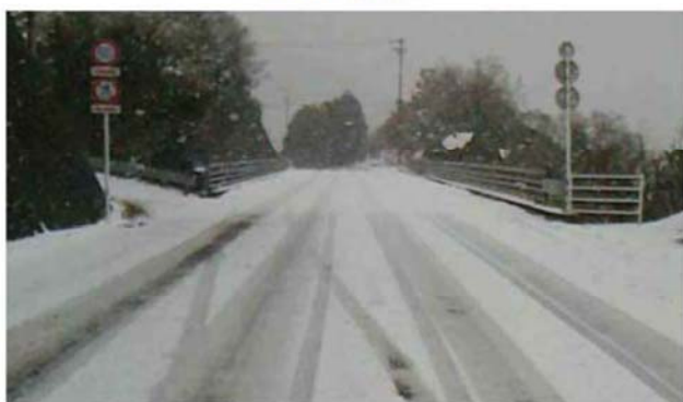
周囲の路面状況
