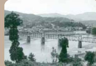
昭和18年頃の写真では、上部工をケーブルで吊る補強を加えています。
