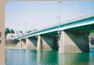
昭和42年に主桁増設によって下流側に向かって2.5mの拡幅を実施しました。
