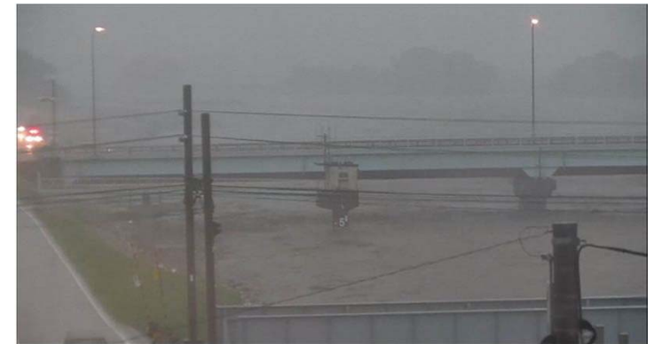
出水状況 （出合大橋：9月17日19:00頃）
