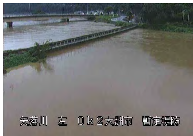
JR矢落川橋梁付近(7月7日11時頃)
