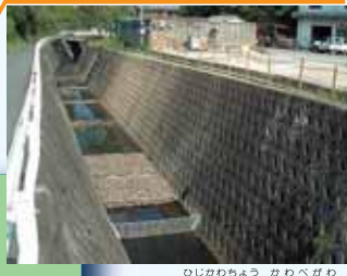
肱川町河辺川 (現地浄化実験施設) (多段土壌層式簡易高度浄化方式)
