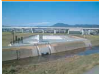
大洲市都谷川 (接触酸化方式)
