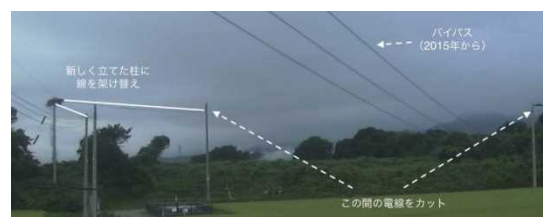
令和2年度 四国電力により電線の架け替え工事を実施（人工巣塔化）
