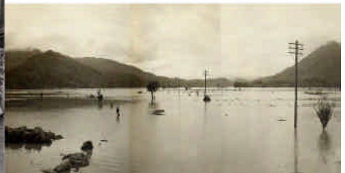
昭和29年6月30日(梅雨前線) 東大洲地区浸水状況 若宮より新谷方面を見る
