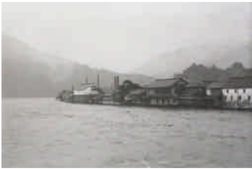
昭和13年8月1日 肱川橋より上流を望む
