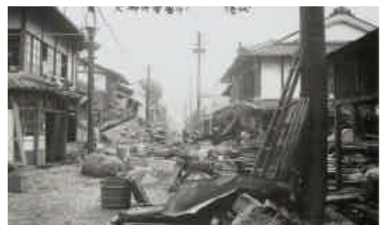
昭和18年7月 家屋損壊状況
