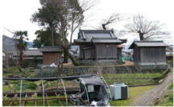
写真 1.2.4 みずよけば 水防場（須賀神社） 今も若宮地区に残る洪水時に避難場所となっていた高石垣の家と言われた神社。
