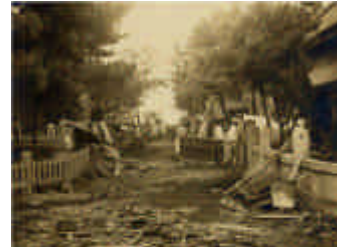
昭和25年9月(キジア台風) 長浜町河口の高潮被害
