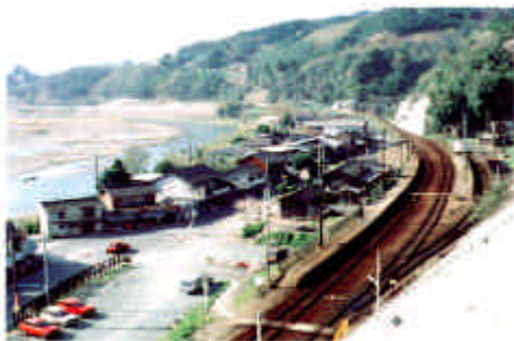
五郎駅前地区施工前(上流より)
