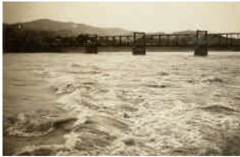
昭和28年6月25日 肱川橋付近の増水
