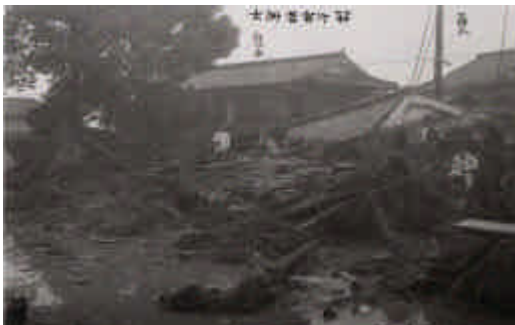
昭和18年7月 家屋損壊状況
