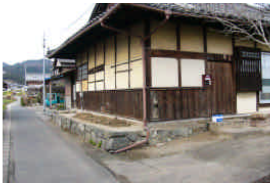
写真 1.2.3 洪水に備えた民家 今も壁に腰板を張って洪水の備えが残る民家。
