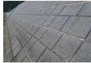
カニ類が移動しやすい粗面護岸
