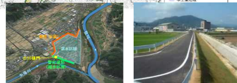
大洲市による 二線堤の整備
