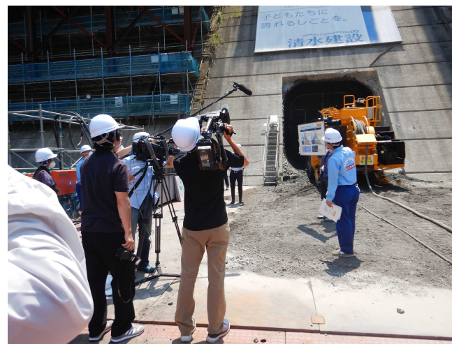
野村ダム改良の現場
