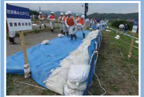
改良積み土のう工
