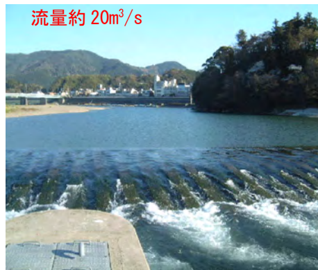
写真 3.1.2 平水流量確保時の状況（大洲床止）
