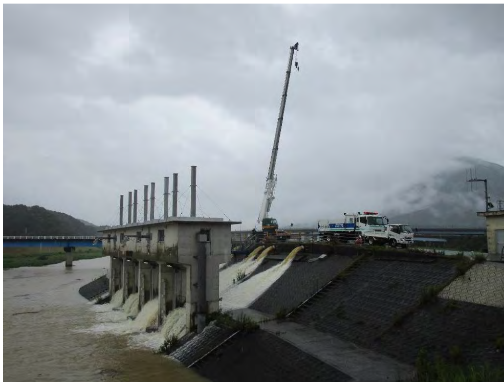
写真 4.3.13 都谷川樋門から内水排除をするポンプ車（平成 30 年 7 月）
