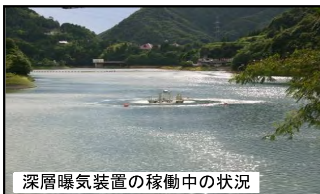
図 2.3.16 野村ダム水質保全対策実施例（曝気循環装置）
