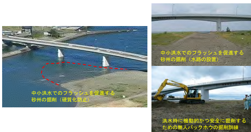
写真 4.3.4 河口砂州の管理対策工
