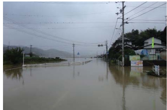
平成 23 年 9 月（台風 15 号） 阿蔵地区浸水状況
