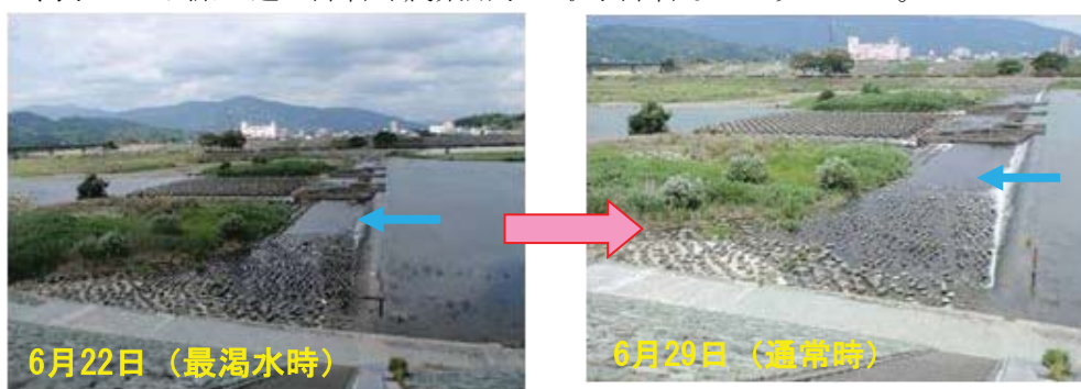
図 2.3 大洲床止めの様子
