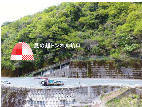
図 3.5 見の越トンネル坑口（終点側） 着手前 (平成 29 年 4 月)
