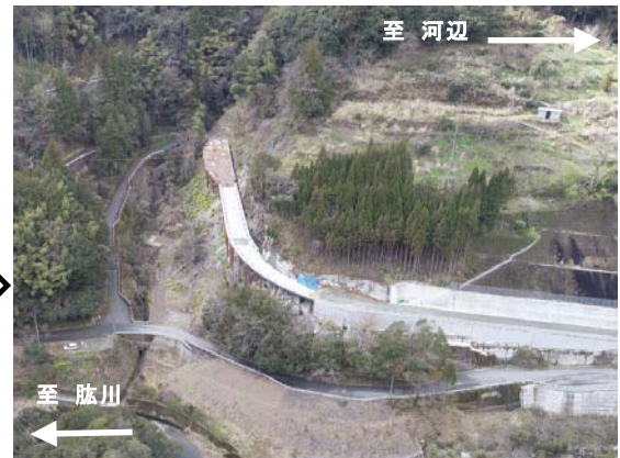
図 3.4 下敷水地区工事用道路 着手後 (令和元年 6 月)
