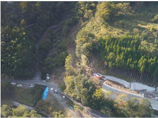
図 3.3 下敷水地区工事用道路 着手前 (平成 29 年 12 月)
