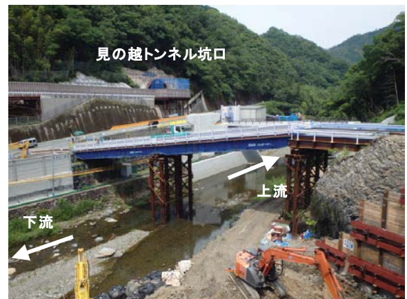
図 3.6 見の越トンネル坑口（終点側） 施工中 (令和元年 6 月)
