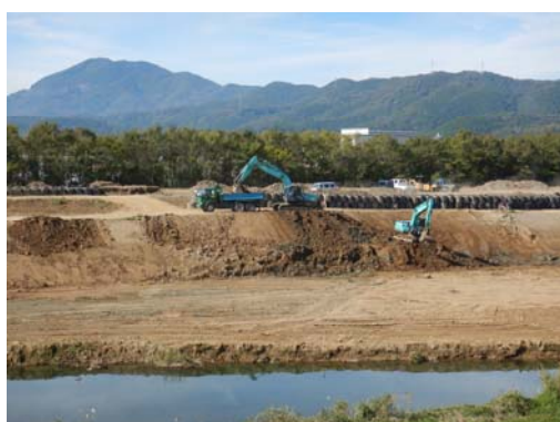
写真 4.1 旧堤防の撤去状況
