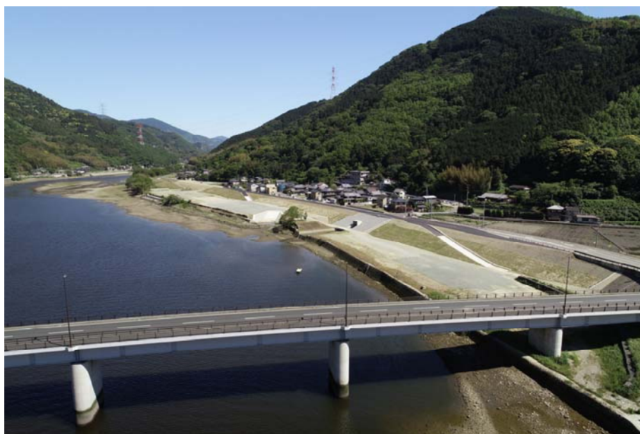
図 2.14 惣瀬地区の堤防整備事業完成
