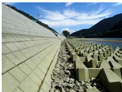
写真 5.2 小長浜低水護岸
