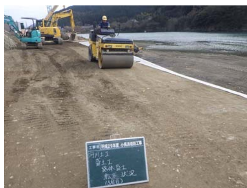
写真 4.2 撤去した土を用いた盛土工
