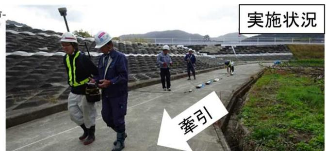
⇒けん引式電気探査等を用い、**連続的な地質を把握**した上で堤防詳細点検を行い、対策必要区間を抽出
