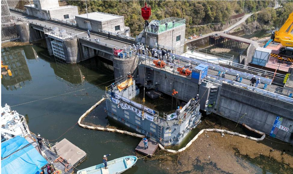
上流仮締切設備(据付中)を望む
