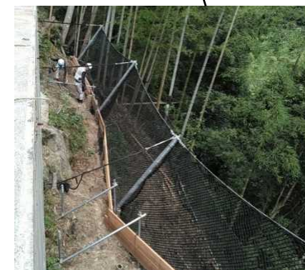
落石防護柵の設置状況
