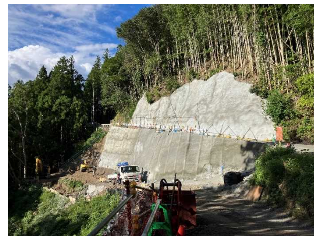
付替道路法面の保護工追加(モルタル吹付、鉄筋挿入)
