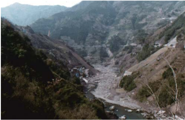
工事前のダムサイド（昭和48年4月）（下流側よりダムを望む）
