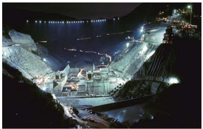
昼夜兼行で打設されるダム（昭和52年12月）（上流側よりダムを望む）
