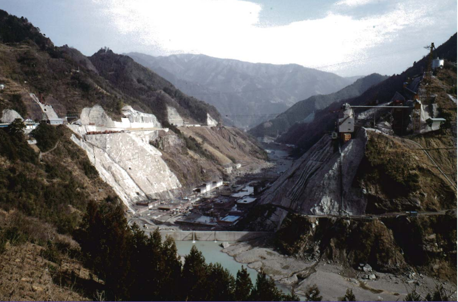
ダム掘削完了時(昭和51年2月)(上流側よりダムを望む)
