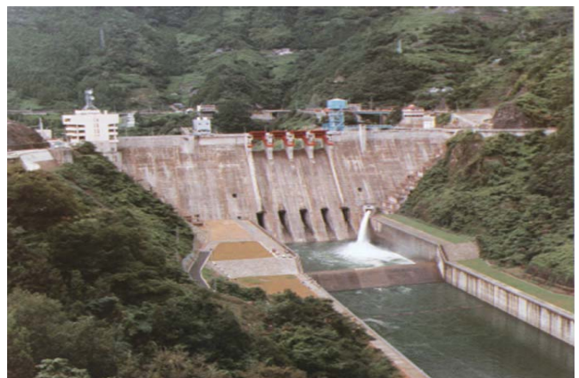
ダム完成（昭和61年11月）（下流側よりダムを望む）
