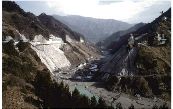
ダム掘削基礎掘削完了（昭和51年2月）（上流側よりダムを望む）
