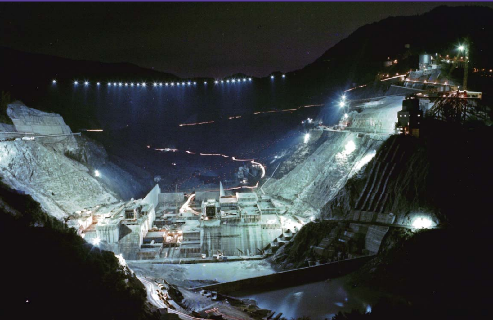
ダム夜間工事(昭和52年12月)(上流側よりダムを望む)
