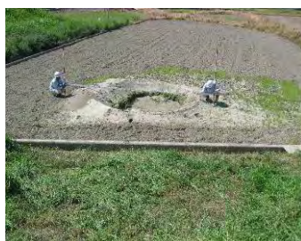
平成17年洪水 土佐市用石地区(漏水被害)
