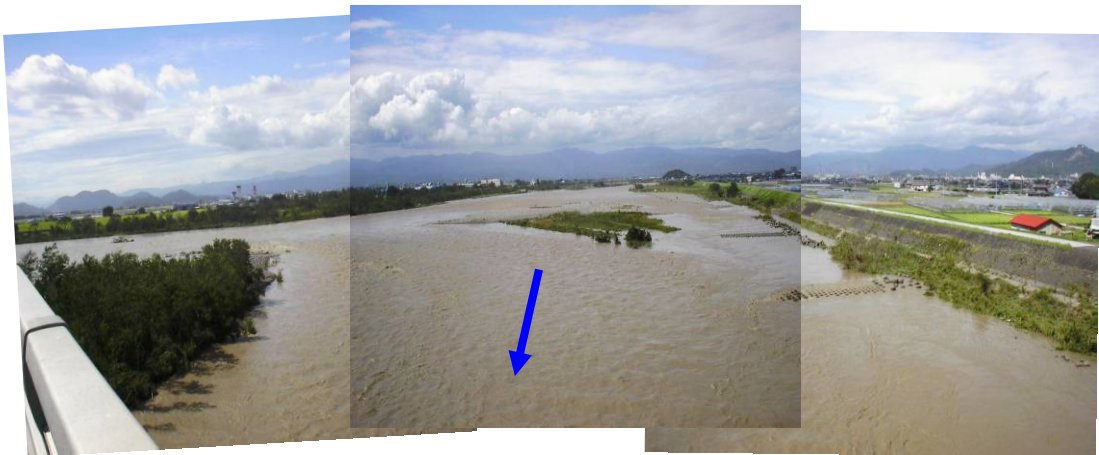
台風14号 物部川出水状況 (物部川大橋から上流を望む)
