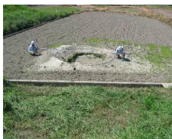
平成17年洪水 土佐市用石地区漏水
