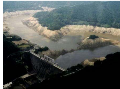
濁水発生状況(平成17年8月)
