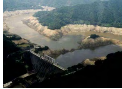
濁水発生状況(平成17年8月)
