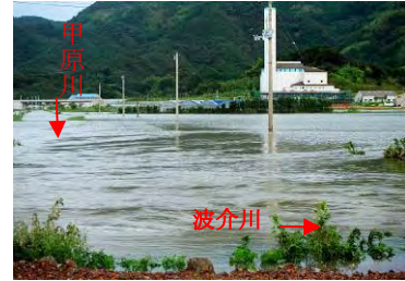
平成17年台風14号 土佐市甲原地区(支川氾濫状況)
