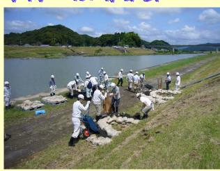
6月13日(火)四万十川実崎地先で「水防工法講習会」を実施しました。本格的な梅雨の出水期を迎え、重要な水防工法について迅速かつ的確に作業ができるよう、訓練しました。当日は、地域の自主防災会の方もこられ、熱心に参加頂きました。土のう作川作業や、ロープワークでは基本的なロープの結び方を習得し、最後に堤防付近での漏水を防ぐ工法「月の輪工法」を全員で実施しました。雨が多い時期ですが、今回の訓練を活かし、今後も地域の安心・安全に努めてまいします。
