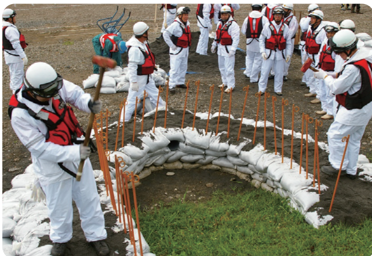
水防工法実施の様子
