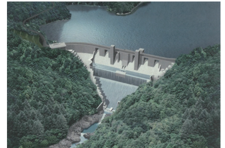
横瀬川ダム(建設中)
