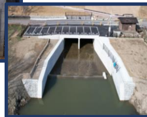
導水路 (高知県施工)
