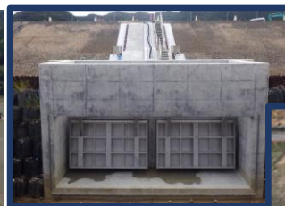
樋門 (国土交通省施工)
