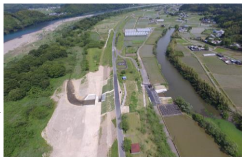
完成写真 (R6年5月)
