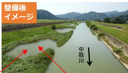
土砂が堆積している箇所を掘削し、ワンド地形を造成する。池のようになっている場所ではヤナギ類が着生できないため、樹林化が抑制され、流れがよくなり、洪水も起こりにくくなる。
