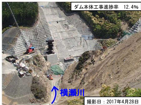
ダムサイト建設地の現況 (右岸より左岸を臨む)
