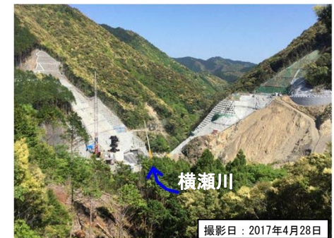
ダムサイト建設地の現況 (見学所より本体を臨む)
