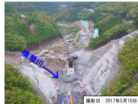
ダムサイト建設地の現況 (下流より本体を臨む)
