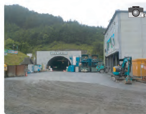
四万十町金上野 撮影時期：平成27年6月
