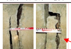
樋門の目地部の亀裂
