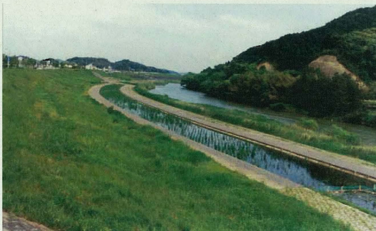
中筋川支川井上川の河川浄化施設
