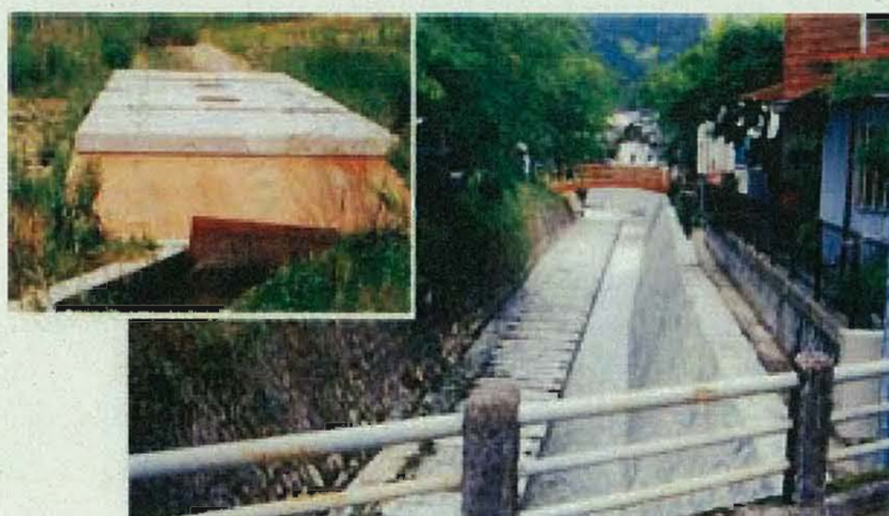
十和村・窪川町 生活排水浄化施設
