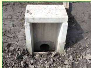
排水口の整備
