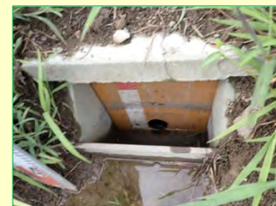
排水調整板の設置
