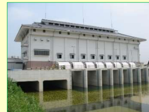
排水機場の管理
