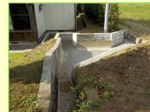
排水路側壁嵩上げ
