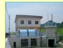
排水機場の整備
