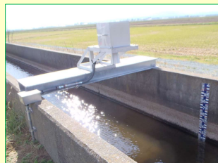
水位計の設置
