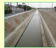
排水路の整備
