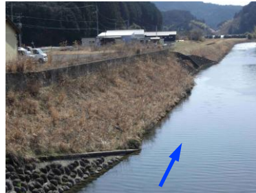
仁井田橋下流側 左岸の護岸 (平成29年度施工)
