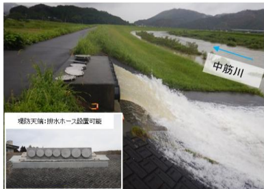
【写真】排水ポンプ車 実排水 排水側状況
