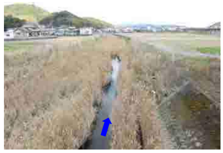
苗代橋より下流河道
