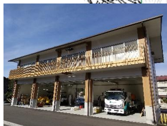
排水機場に隣接する防災倉庫
