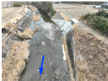
仁井田橋上流側 両岸の護岸 (令和3～7年度施工)
