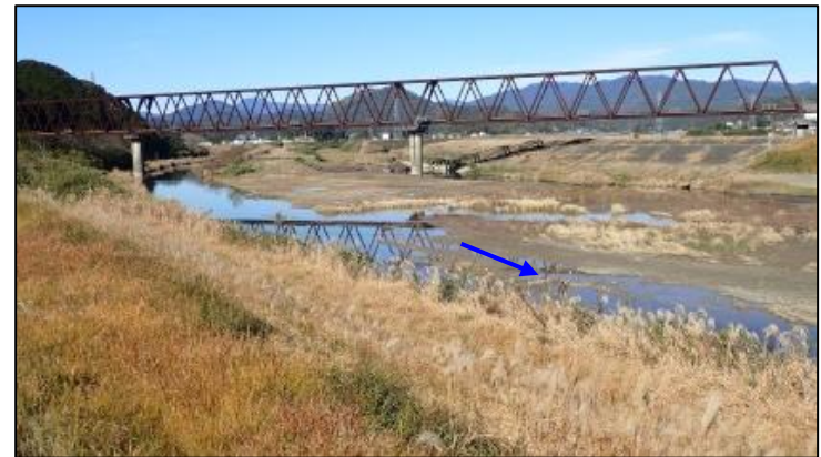
河道状況【16K/050付近】
