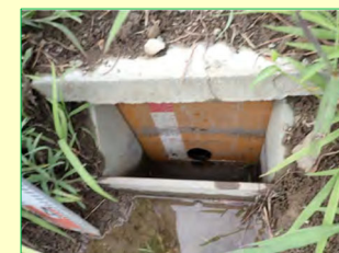
排水調整板の設置
