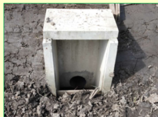
排水口の整備
