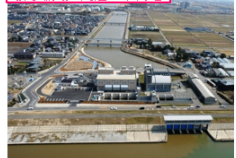
排水機場と周辺の市街地
