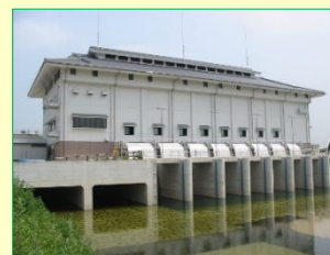
排水機場の管理
