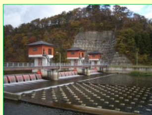
頭首工の管理
