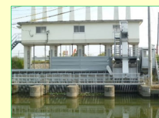
排水樋門の管理
