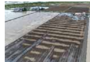
地下かんがいシステムの導入
