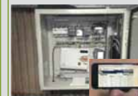
監視装置の設置
