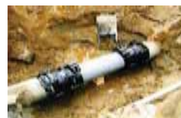
漏水防止のための整備
