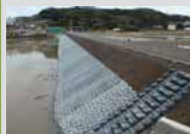
ため池護岸の整備
