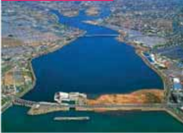
排水機場と周辺の市街地
