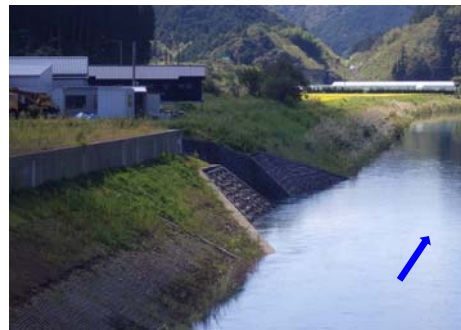
仁井田橋下流側 左岸の護岸 (平成29年度施工)
