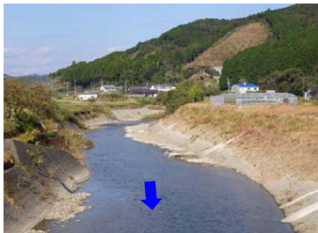
仁井田橋上流側 左岸の護岸 (平成30年度施工)
