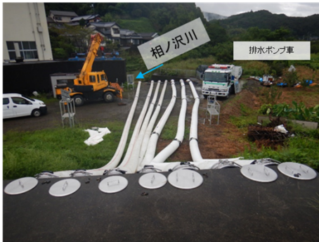
【写真】排水ポンプ車 実排水 ポンプ設置状況
