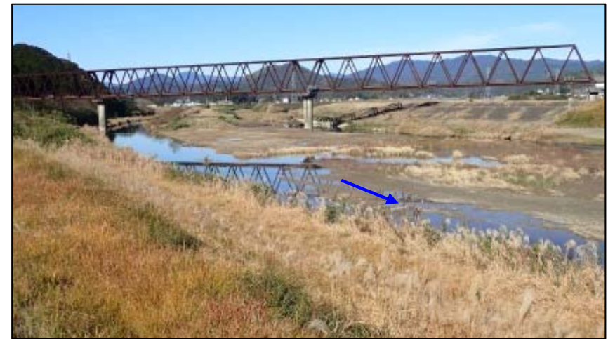
河道状況【16K/050付近】
