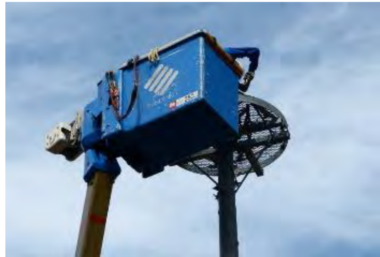
(株)四電工による巣塔点検の様子
