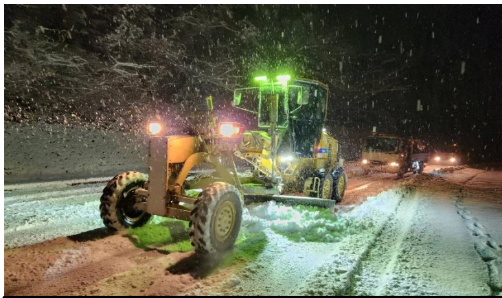
片坂バイパスの除雪状況(R6.1)
