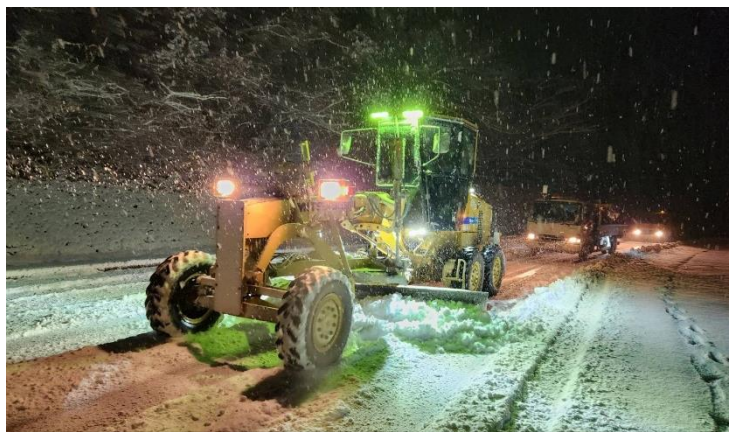
片坂バイパスの除雪状況(R6.1)
