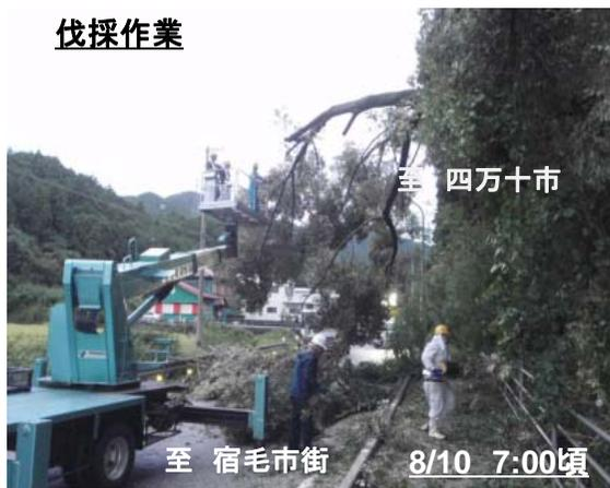
倒木が四国電力の高圧電線を巻き込んだ状況となり、伐採作業にあたっては、慎重を期す。高所作業車を導入し、速やかな作業を実施。
