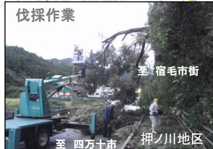
・倒木が高圧電線を巻き込んだ状況となり、伐採作業にあたっては慎重を期す。高所作業車を導入し速やかな作業を実施。
