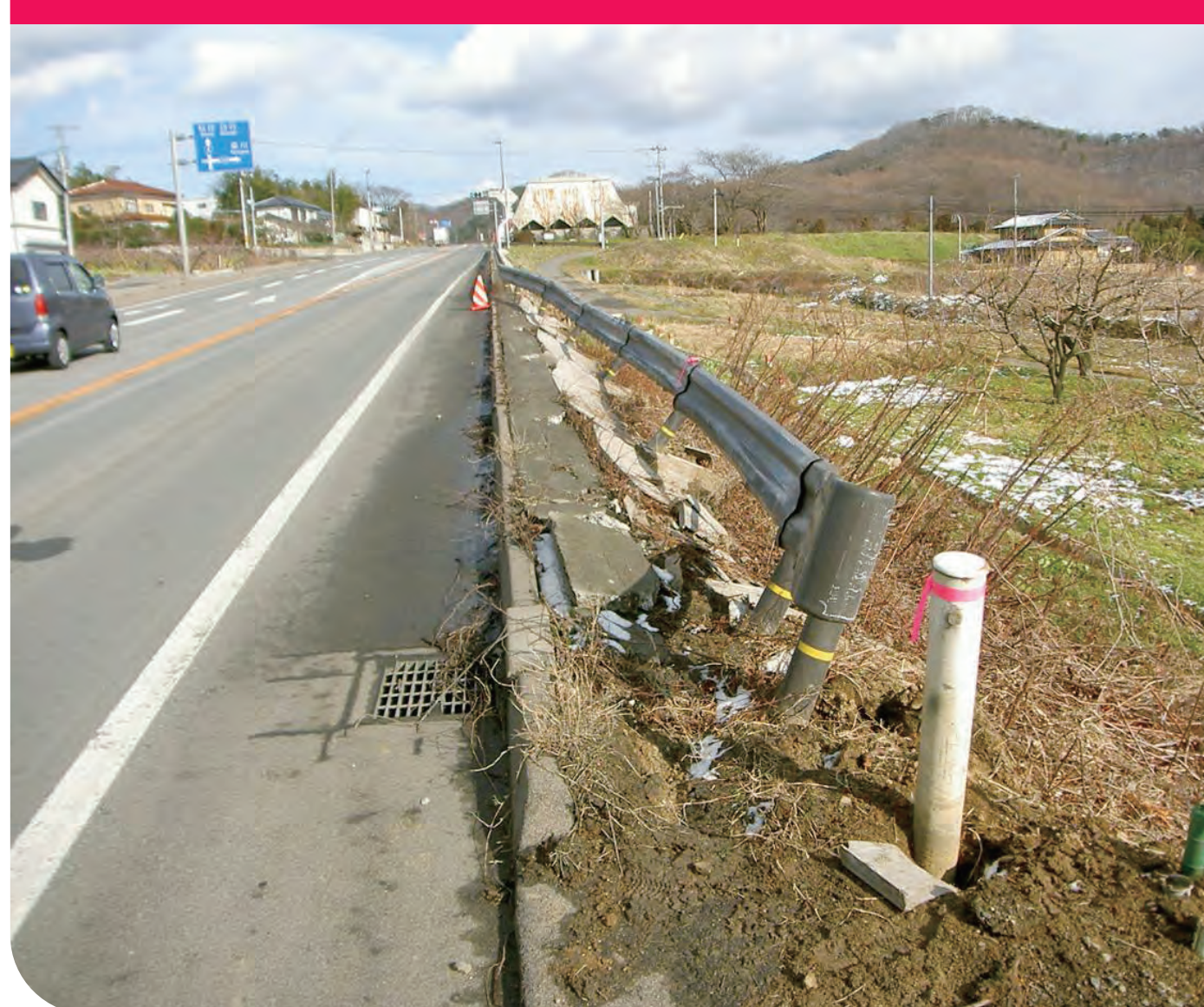
ガードレール・標識等の損傷
