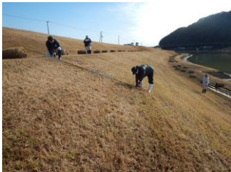
法面貫入状況
