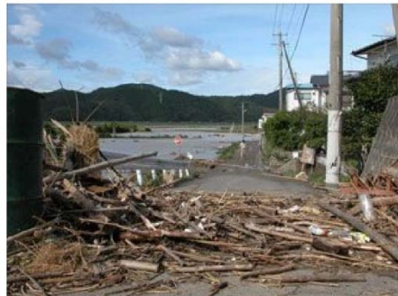
四万十川：不破地区の外水による流木堆積
