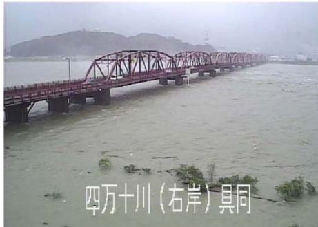
四万十川：赤鉄橋の外水による洪水状況
