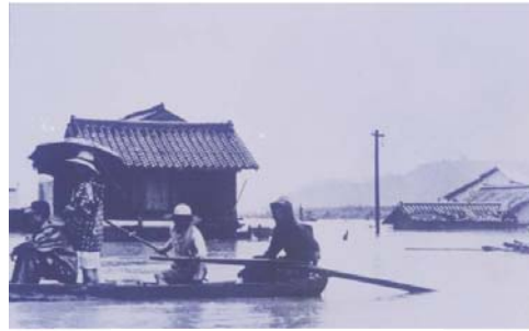
小津賀堤防決壊の状況
