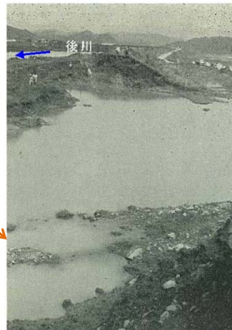
小津賀堤防決壊の状況
