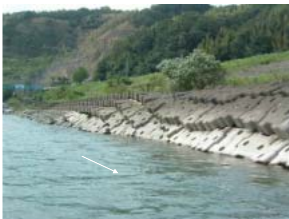
洪水による局所洗掘状況
