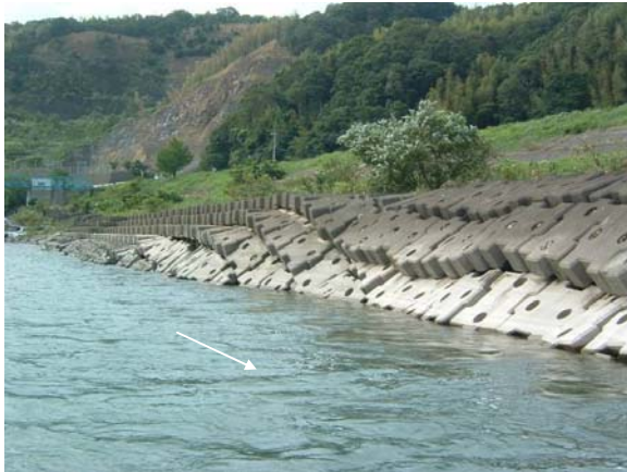
洪水による局所洗掘状況
