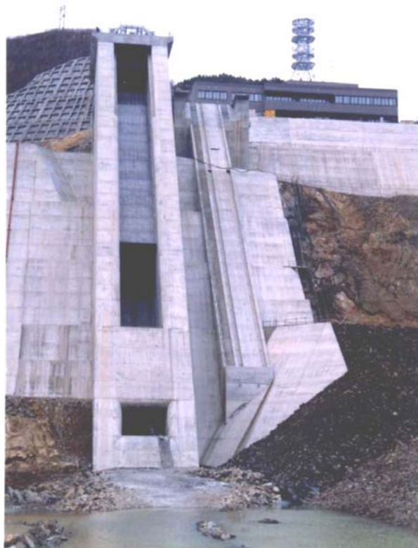
選択取水設備の設置（東北地方整備局：七ヶ宿 しちかしゆく ダムの事例）
