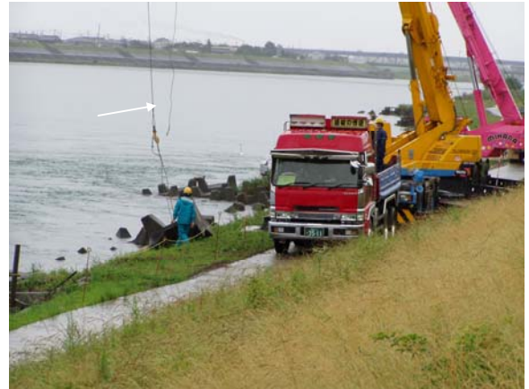
被災箇所の応急復旧
