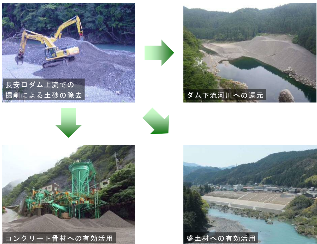
図－4. 2. 2 長安口ダムで除去した土砂の下流河川への還元、有効活用のイメージ
