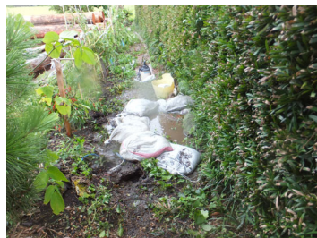
大京原地区（阿南市那賀川町） 平成26年8月洪水による堤防漏水と水防状況
