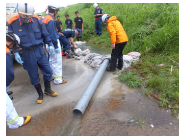
大京原地区（阿南市那賀川町） 平成26年8月洪水による堤防漏水と水防状況
