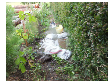
大京原地区（阿南市那賀川町） 平成26年8月洪水による堤防漏水と水防状況
