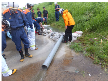
大京原地区（阿南市那賀川町） 平成26年8月洪水による堤防漏水と水防状況
