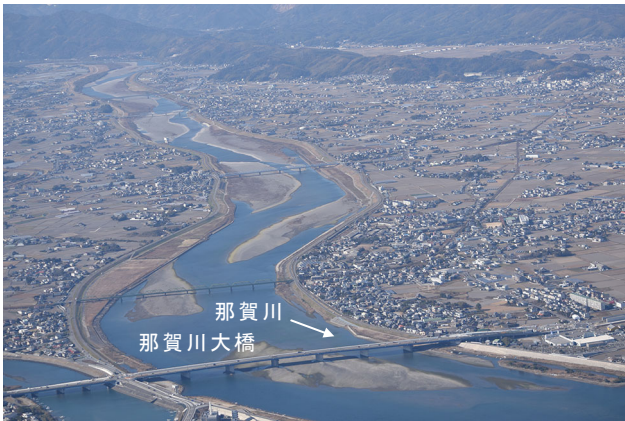
那賀川大橋付近
