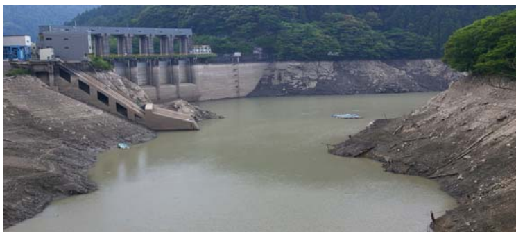
【枯渇した長安ロダム（那賀川上流）】
