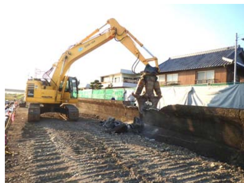
【岩脇地区パラペット補修】
