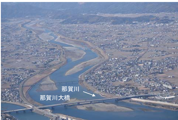
【那賀川大橋付近】
