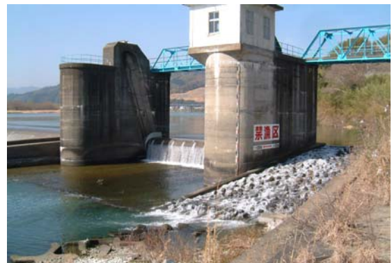
【北岸堰の魚道の状況】
