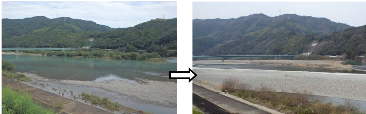
【樹木伐採前後状況（吉井地区）】
