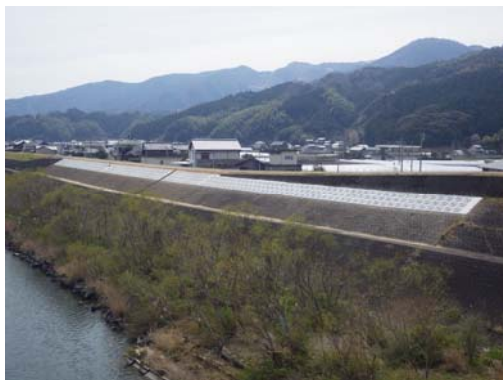
【吉井地区法面補修】
