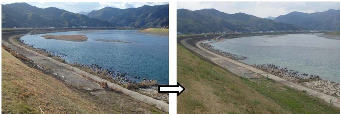
【河道掘削前後状況（楠根地区）】
