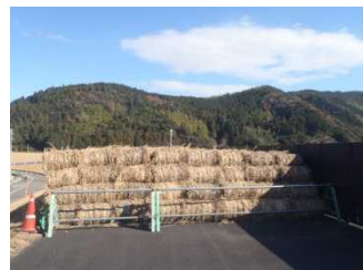
④津乃峰橋北詰の堤防上 (阿南市長生町川ハタ地先)
