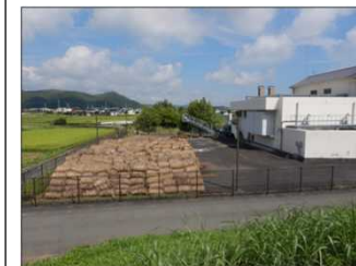
⑤大津田排水機場 (阿南市長生町平久保地先)
